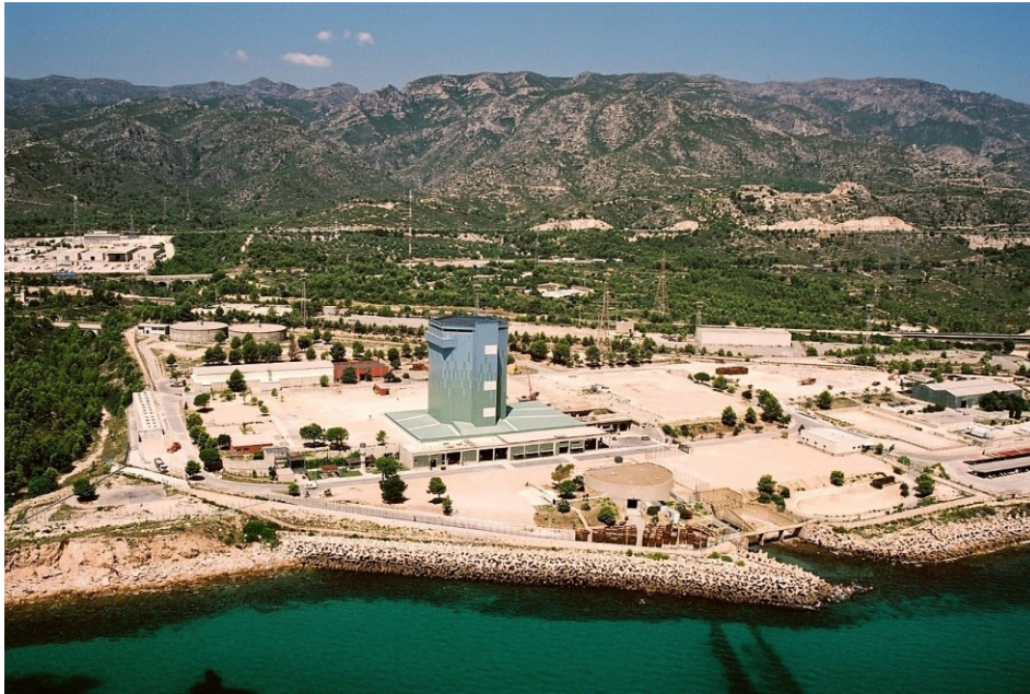
Imagen de la Central Nuclear Vandellós I en desmantelamiento, actualmente en proceso de latencia.
