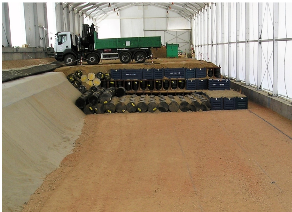
Imagen del interior de la celda de almacenamiento de RBBA en El Cabril.
